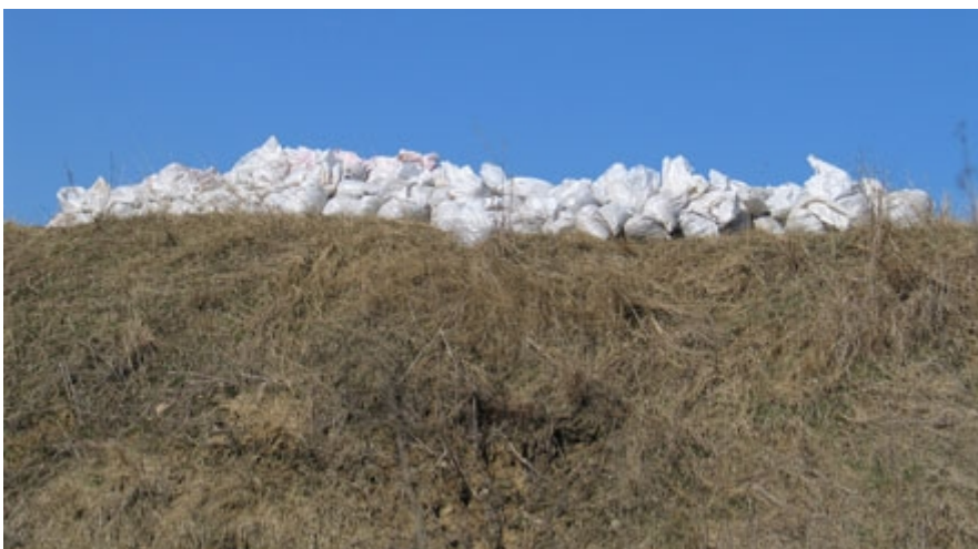
Foto 9: Den polske radiostation RMF har på sin hjemmeside lagt dette billede ud, der viser, at man har lagt sandsække langs kanten på gyllelagunen ved den danske svinefarm ved byen Kujnanki for at forhindre, at gyllen skal sive ud og ødelægge det grundvand, der forsyner 300.000 indbyggere i Bydgoszcz med rent vand.
